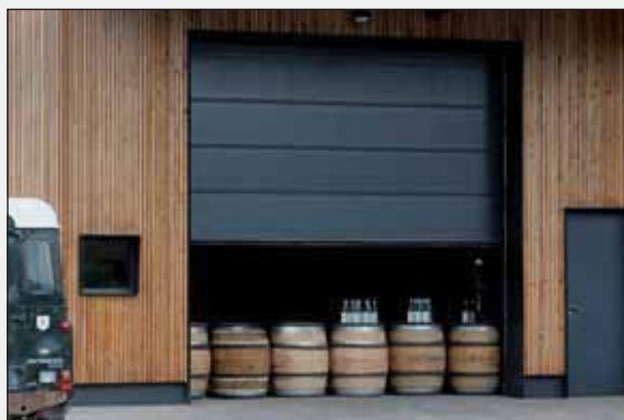
Sekcijska vrata SW „brez utora“, kot zaključek vinske kleti.
