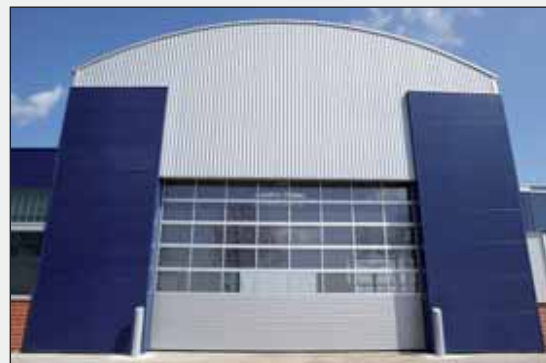
Sekcijska vrata SLW s spodnjim delom iz sekcij, polnjenih s PU peno.
