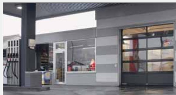
Sekcijska vrata SL na bencinski črpalki.
